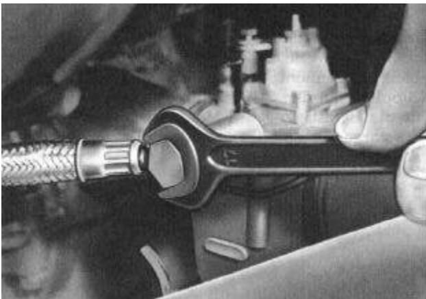
Bild M 4. Kraftstoffleitung abschließen
