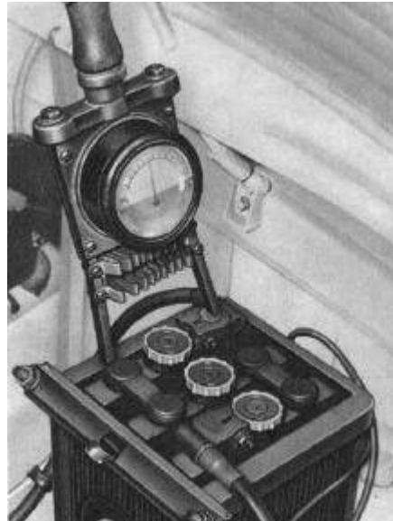
Bild E 13. Batteriespannung überprüfen
