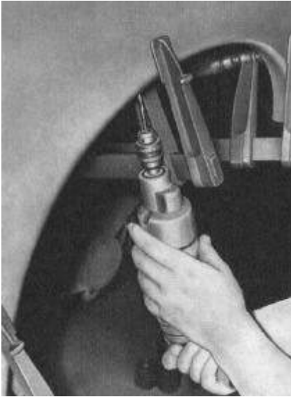
Bild K 16. Nietlöcher bohren
