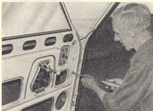
Bild K 3. Abschrauben der Glasrinne
